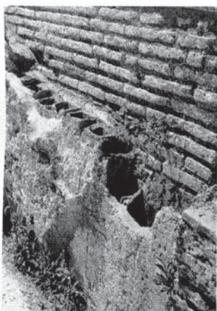
Fig. 9. Esempio di parete rivestita in tubuli intonacati per la circolazione dell'aria calda lungo le pareti (rielaborazione da ADAM 1984, p. 293).
