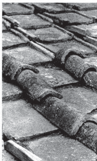
Fig. 4. Ricostruzione di un tetto con tegole piatte con alette (tegulae) e coppi (imbrices) (da ADAM 1984, p. 231).
