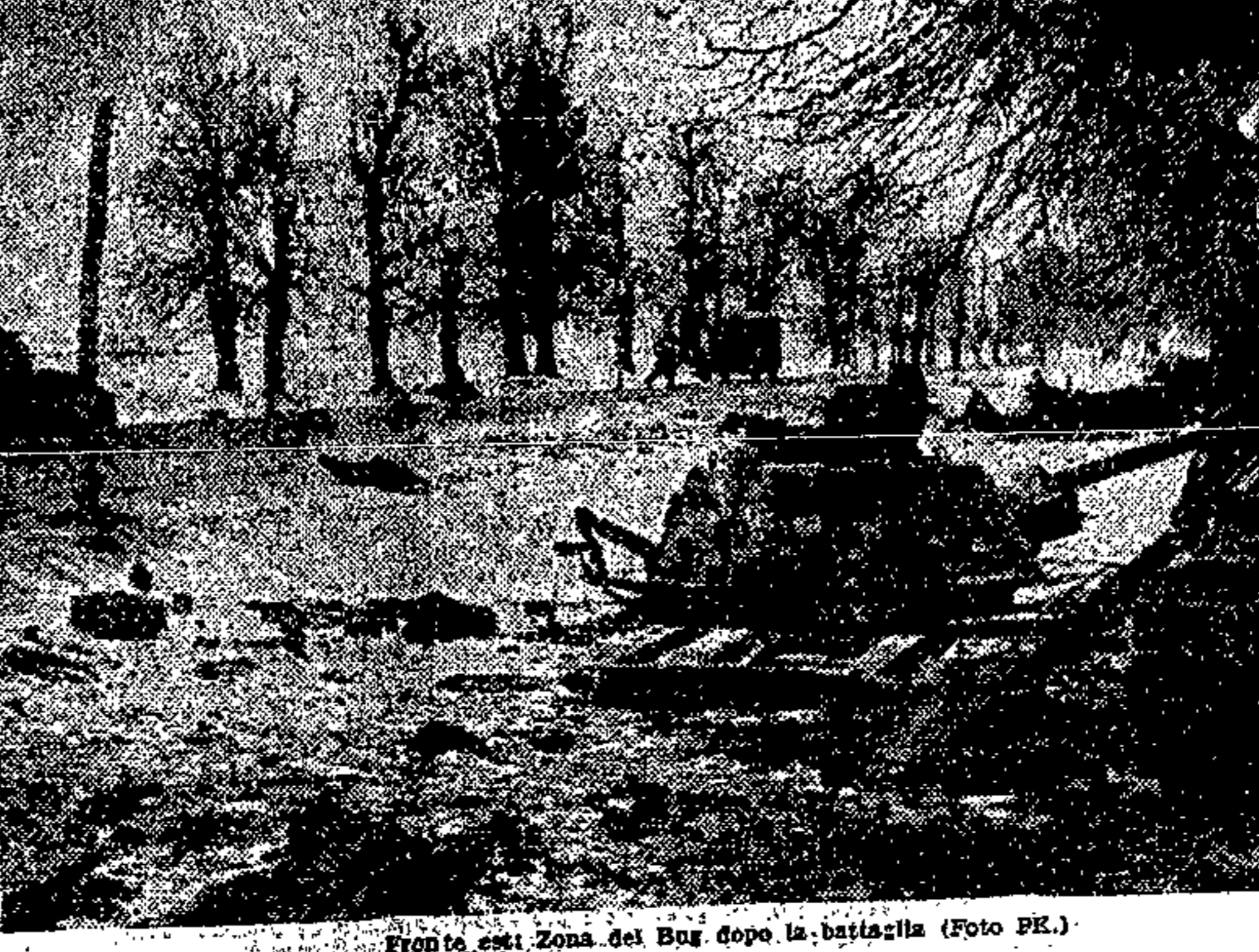
Fronte est. Zona del Bug dopo la battaglia (Foto P.E.)
