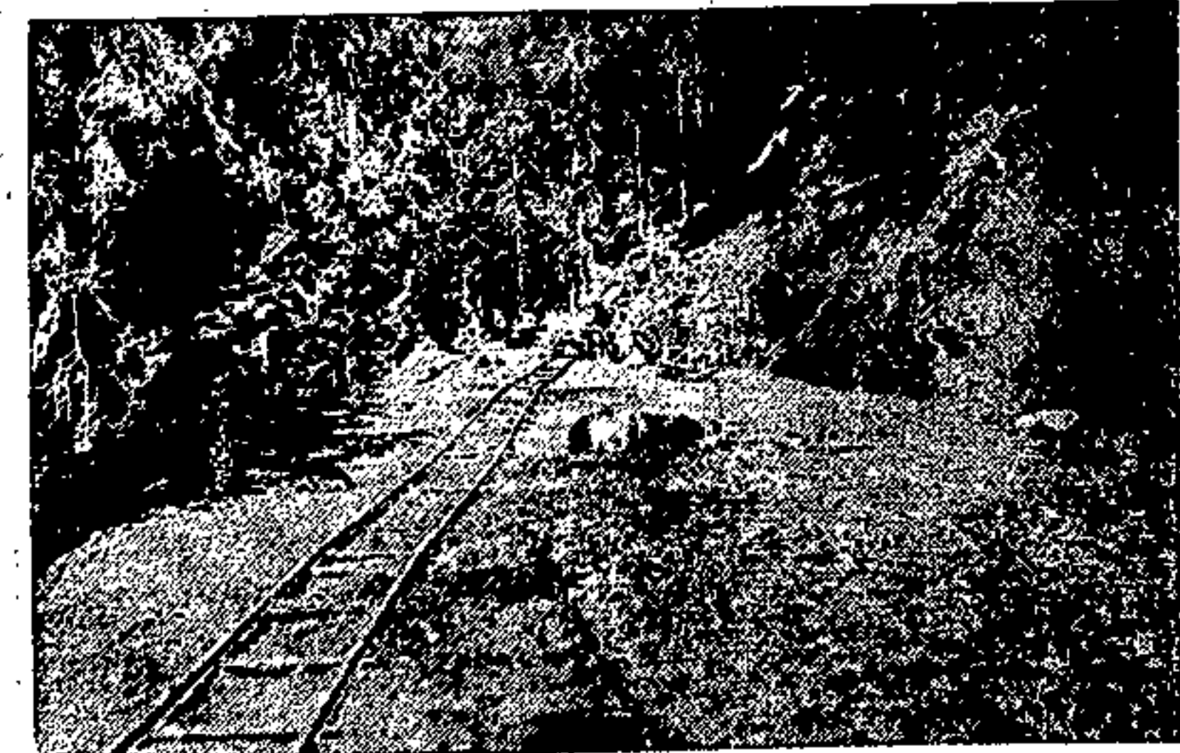
Un aspetto dei lavori per il ripristino della strada romana di Montecroce Carnico
