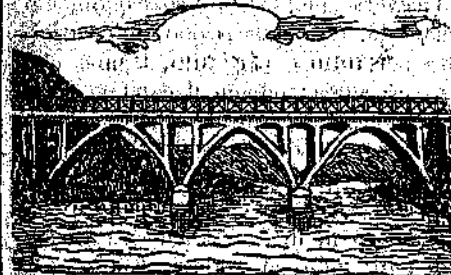
Ponte allo stretto di Pinzano.
