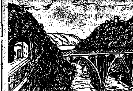
Galleria e Ponte.
