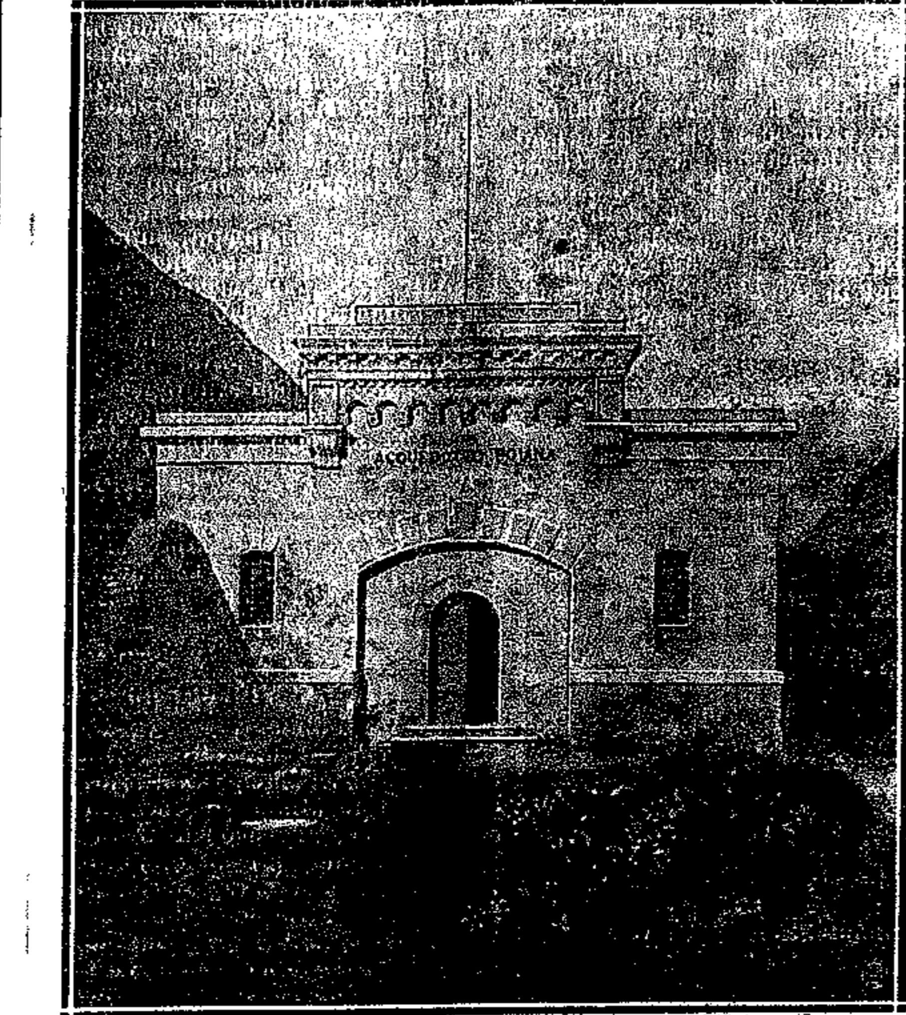
Edificio di presa
