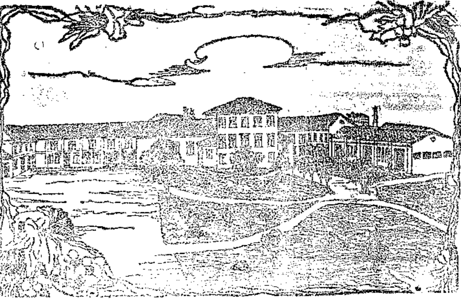
IL GRANDE PIAZZALE ED IL GIARDINO
