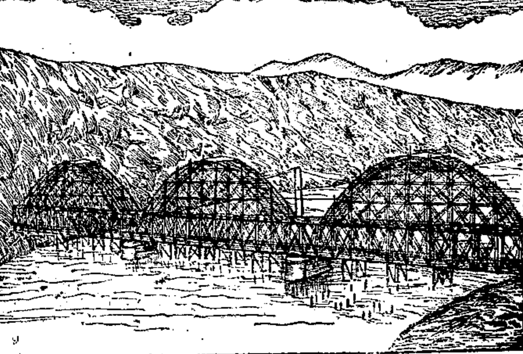
I lavori al Ponte di Pinzano.
