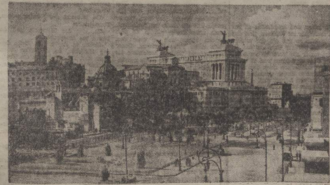
Die via dell'Impero in Rom
