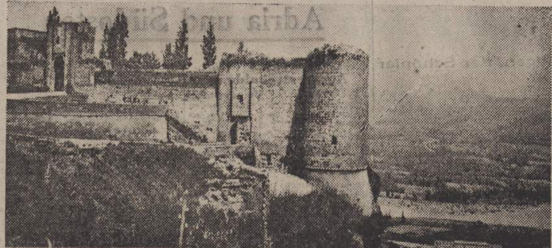
Wuchtig und kräftvoll erheben sich die verwitterten Mauern der alten Festung hoch über dem Tal
