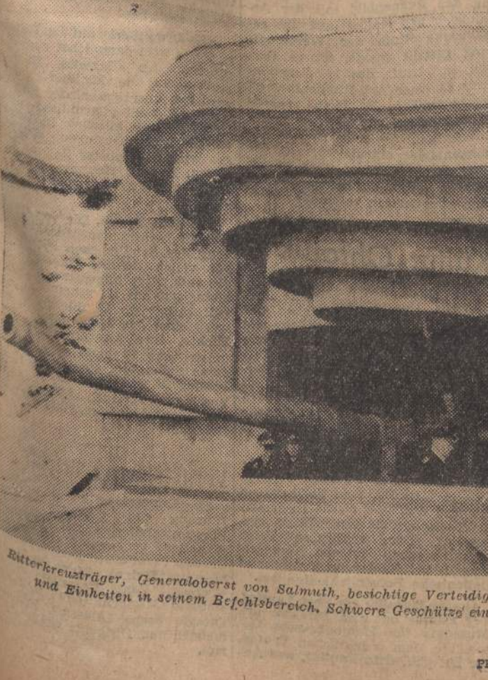
Batteriekreuzträger, Generaloberst von Salmuth, besichtigt Verteidigungsanlagen des Atlantikwalls und Einheiten in seinem Befehlsbereich. Schwere Geschütze einer Marine-Artillerieabteilung
