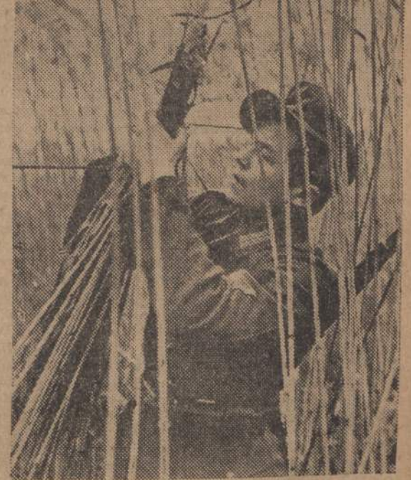
Leitungsmasten. Es werden einfach ein paar Schilfhälme zusammengebündelt und geknickt.
