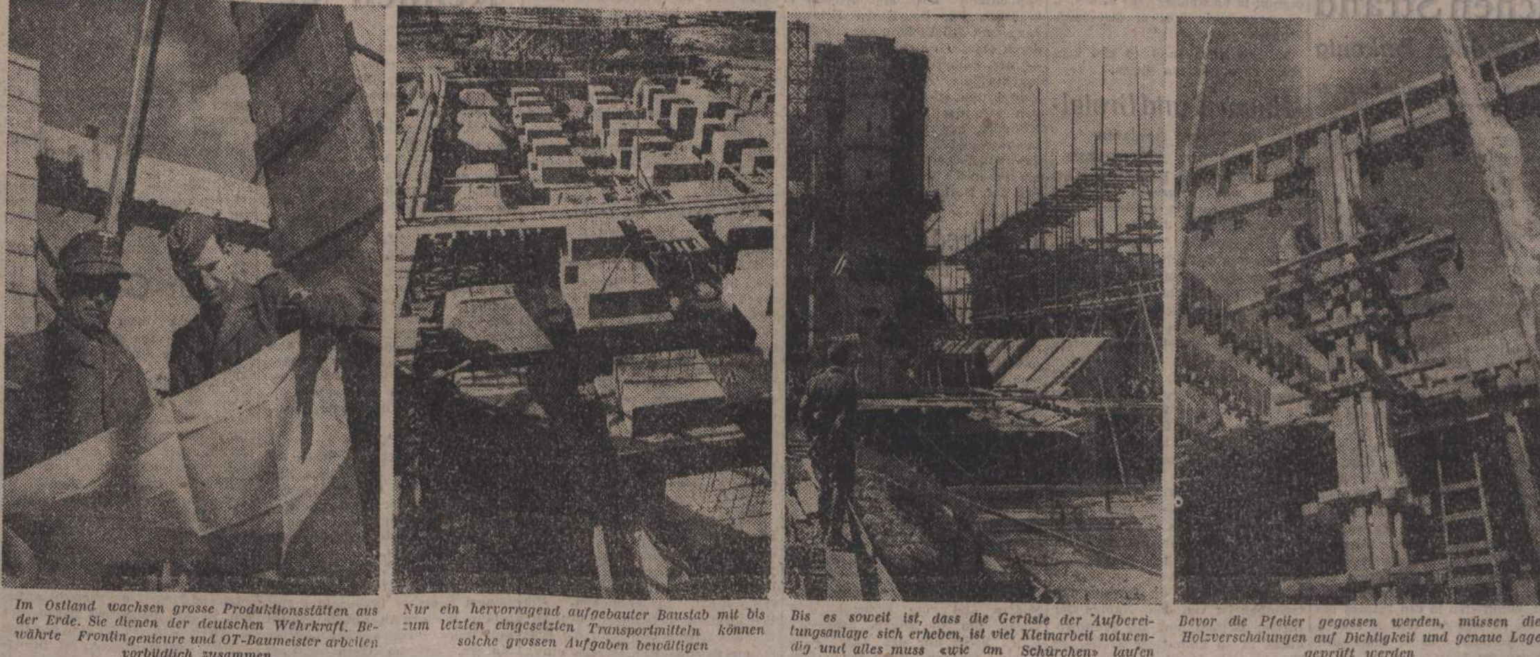
Im Ostland wachsen grosse Produktionsstätten aus der Erde. Sie dienen der deutschen Wehrkraft. Bewährte Frontingenieur- und OT-Baumeister arbeiten vorbildlich zusammen.
