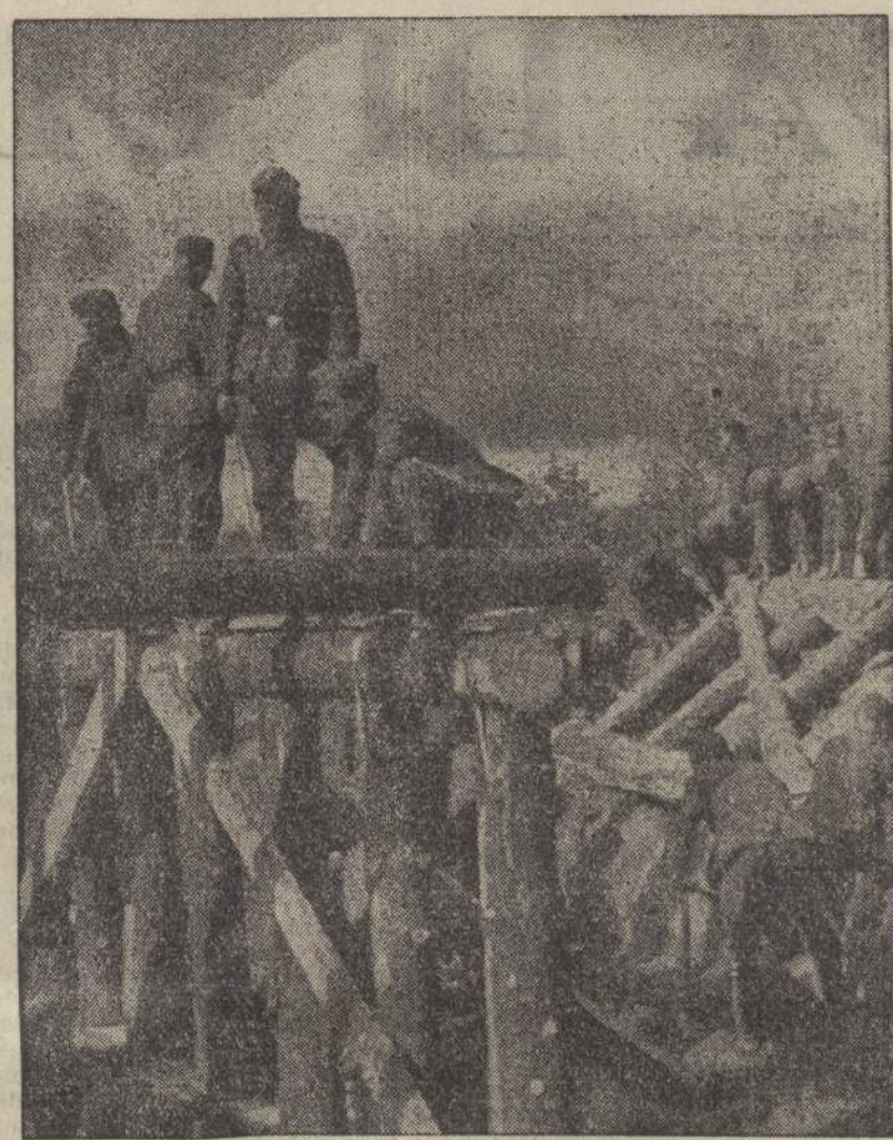
Sulle aspre vie dell'Est: si ricostruisce un ponte
