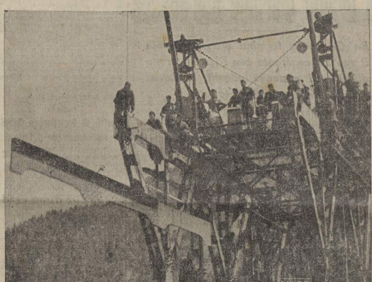
Le comunicazioni ferroviarie ristabilite con la nuova provincia d'Italia. Il Genio Ferroviario ricostruisce il viadotto di Borovnica a Lubiana
