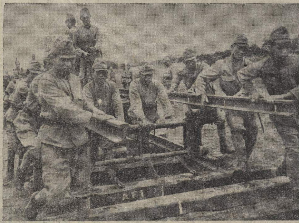
Genieri nipponici al lavoro lungo le retrovie del fronte. La posa di nuove rotaie.
