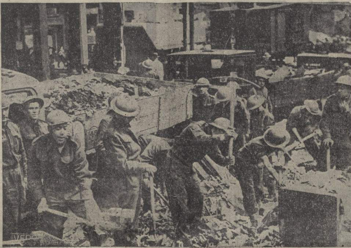
Per riparare i danni dei bombardamenti. Londra ha organizzato squadre di operai militarizzati
