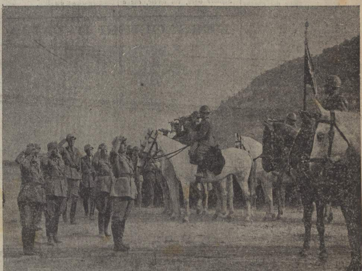
Il Duce passa in rivista reparti di artiglieria che hanno partecipato alle recenti azioni belliche
