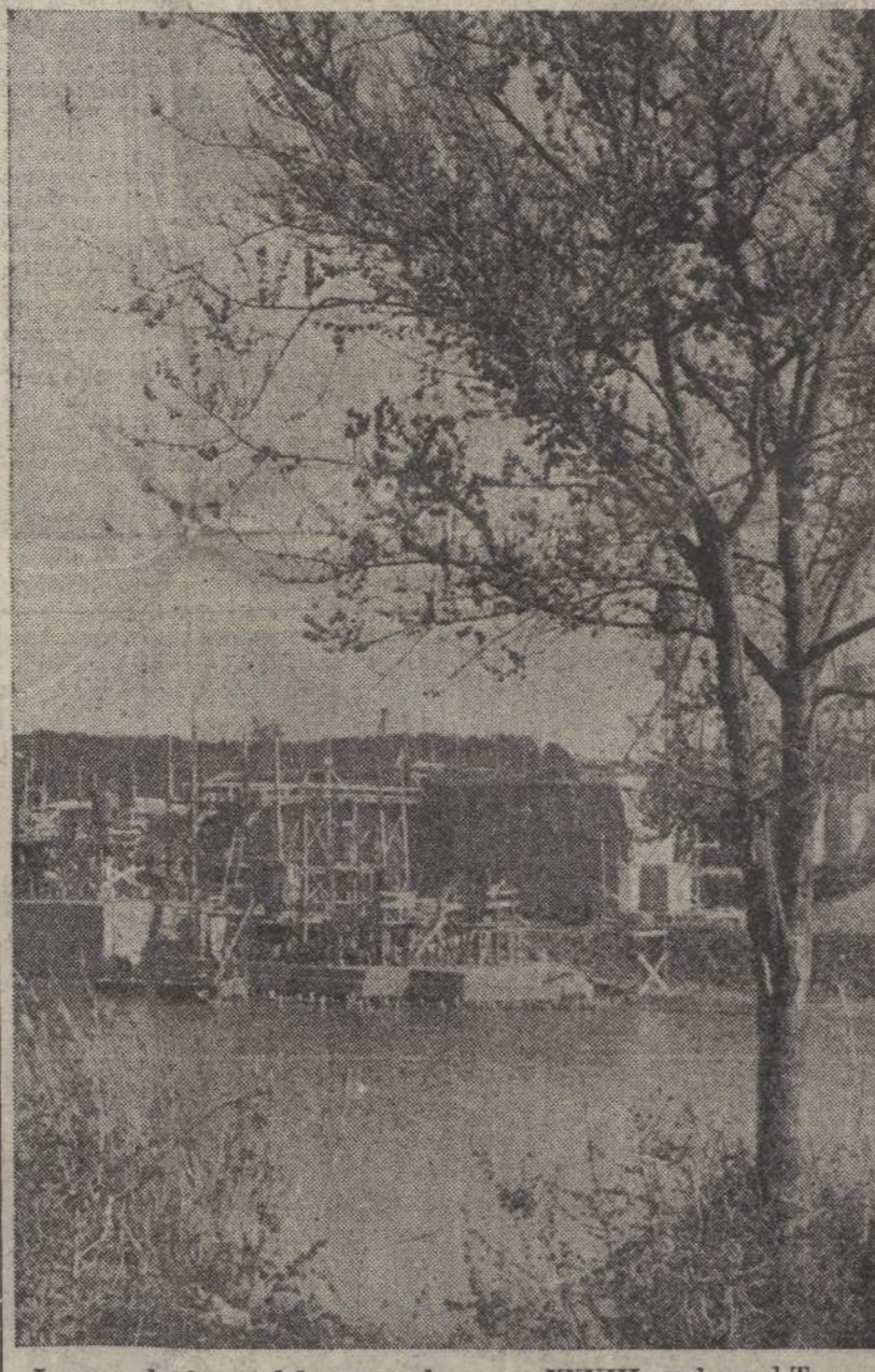
Lo stato dei lavori del costruendo ponte XXVIII ottobre sul Tevere
