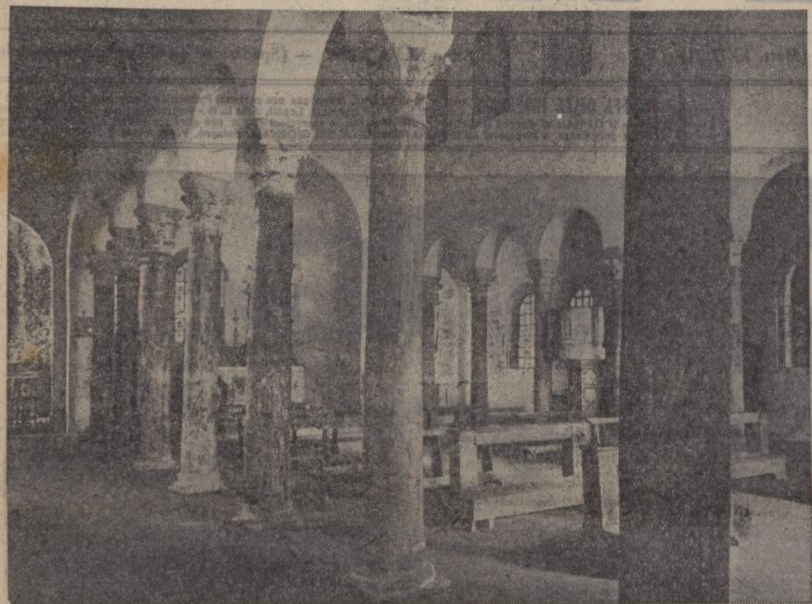
Chiesa dello Spirito Santo: interno dopo il restauro
