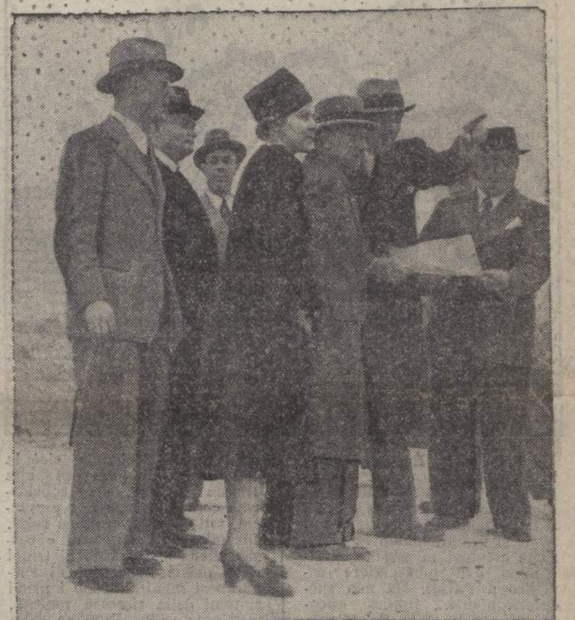
Il Capo del Governo ungherese, Teleki, visita i lavori dell'E.42
