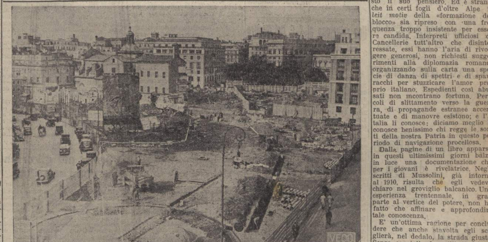
ROMA - La nuova strada XXII Marzo voluta dal Duce che ne iniziò i lavori con i primi colpi di piccone il 24 aprile scorso. La nuova strada congiungerà la Via delle Terme con Via Veneto
