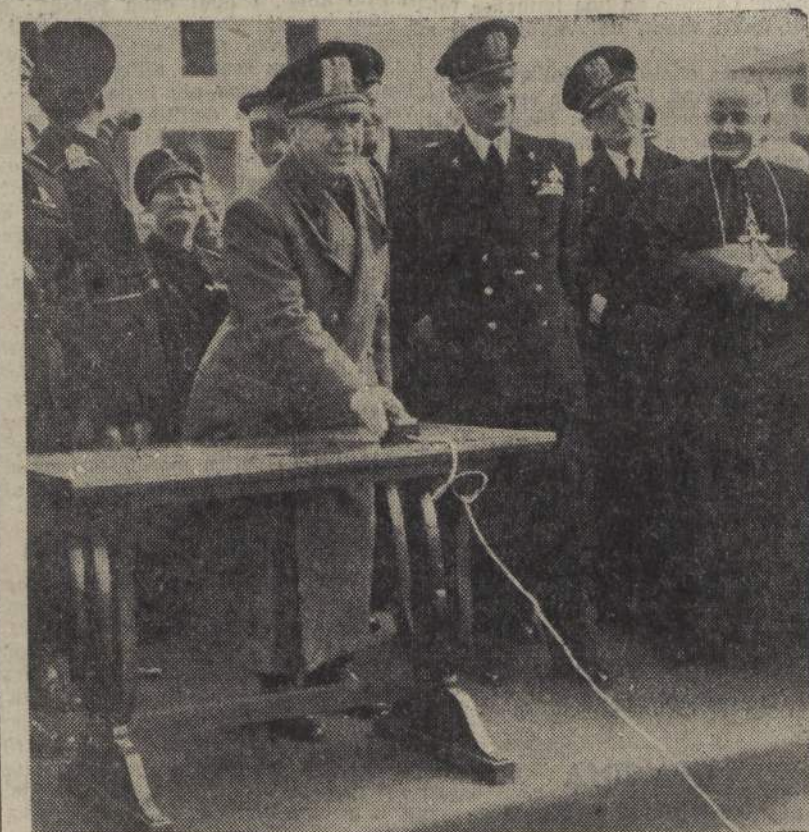
Il Ministro dei Lavori Pubblici S. E. Serena inaugura il nuovo acquedotto di Littoria
