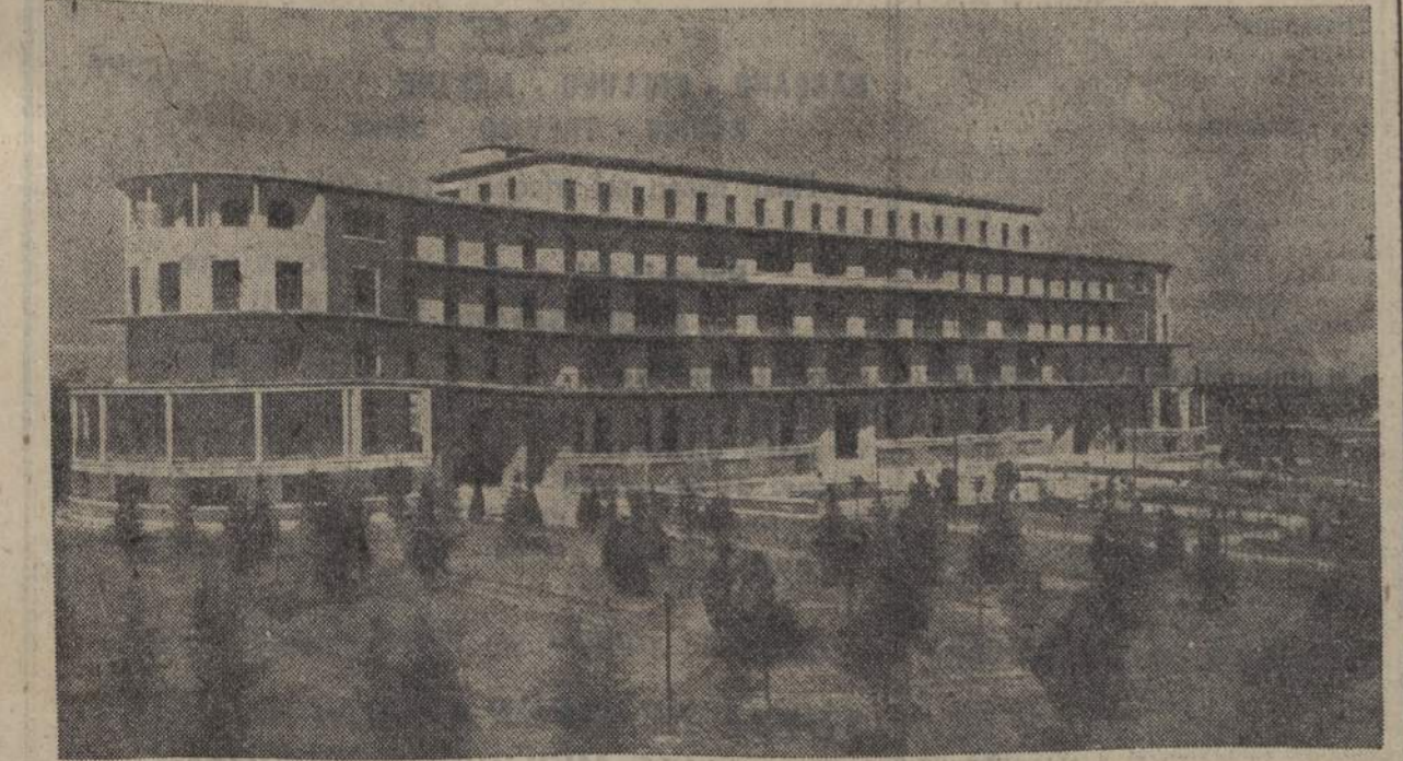
VEDICHAZZANO DI FORLÌ - Centro Sanatoriale - Padiglione per bambini
