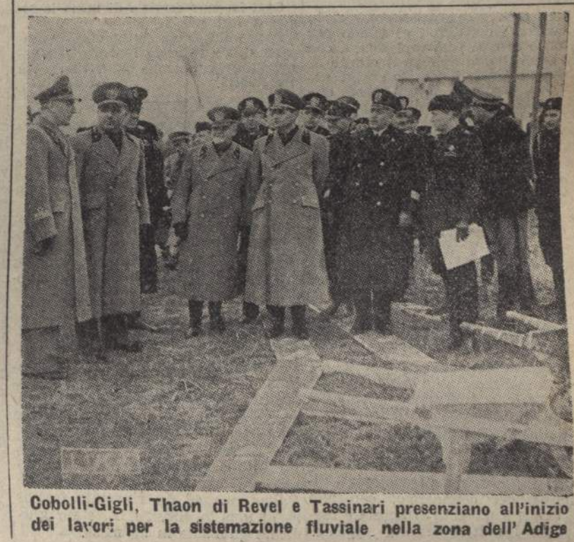
Cobolli-Gigli, Thaon di Revel e Tassinari presenziano all'inizio dei lavori per la sistemazione fluviale nella zona dell'Adige
