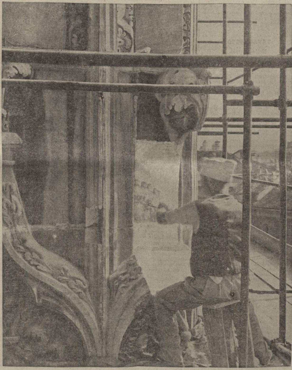
Un aspetto dei lavori in corso
