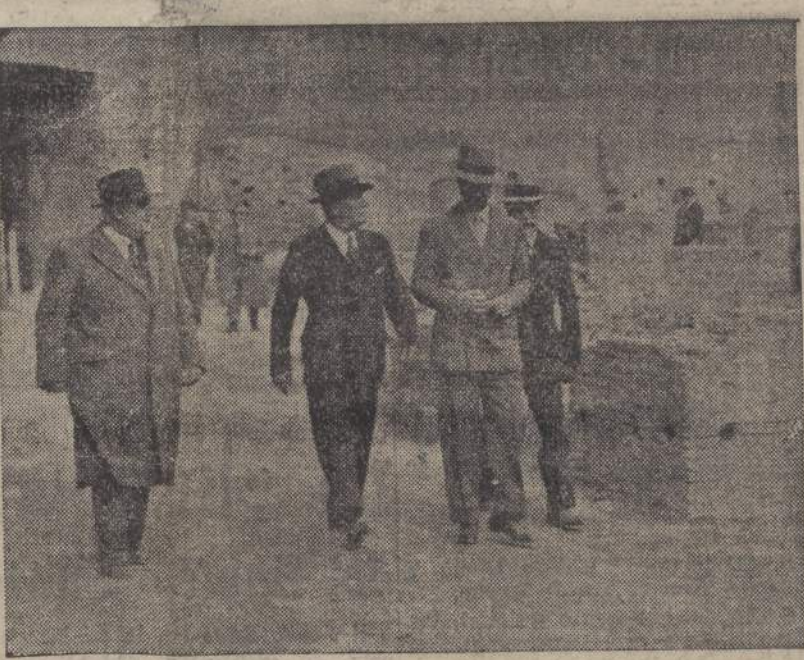
Il Duce visita i lavori in corso della Domus Augustana.
