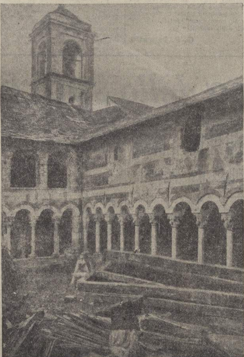
I lavori di restauro nel Chiostro
