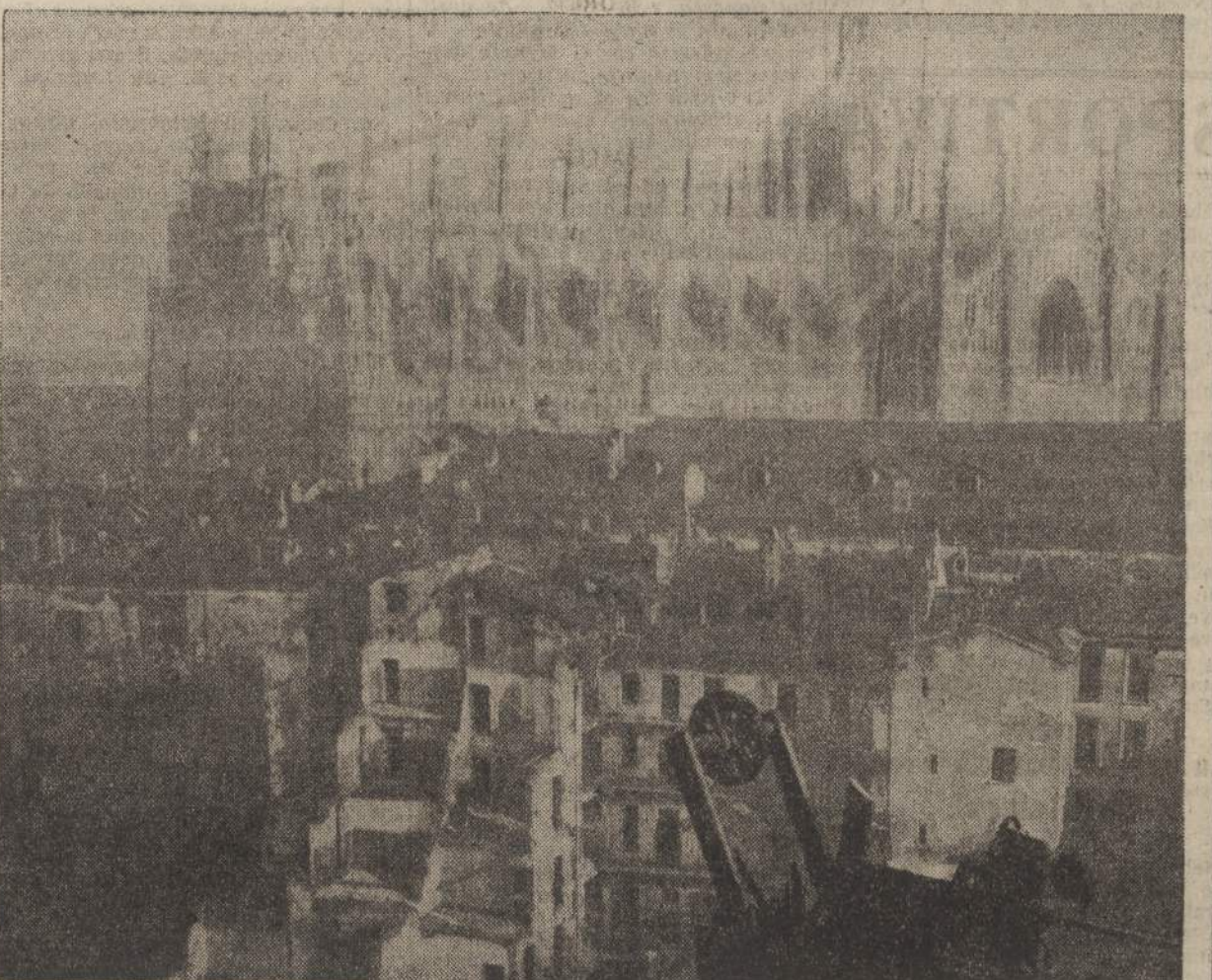
LE DEMOLIZIONI NELL'AREA DEL MONUMENTO
