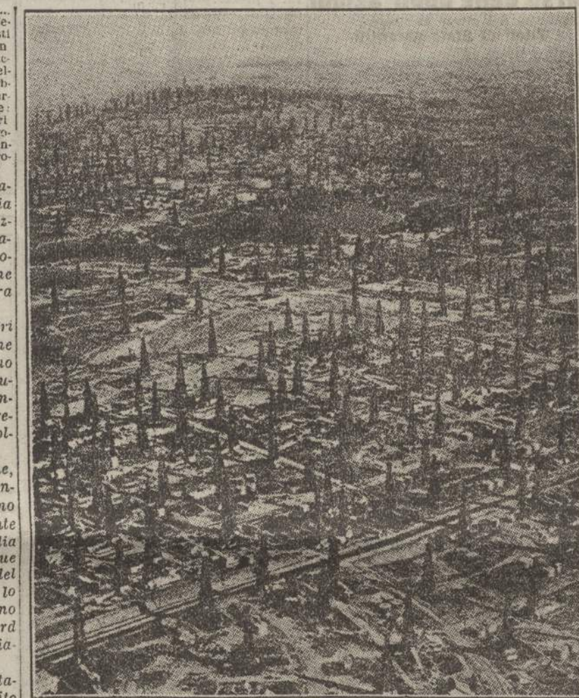
La selva delle torri metalliche che sovrastano i pozzi petroliferi.
