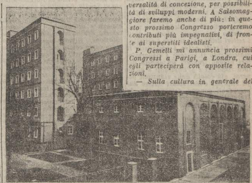
Il complesso edilizio dei Pensionati
