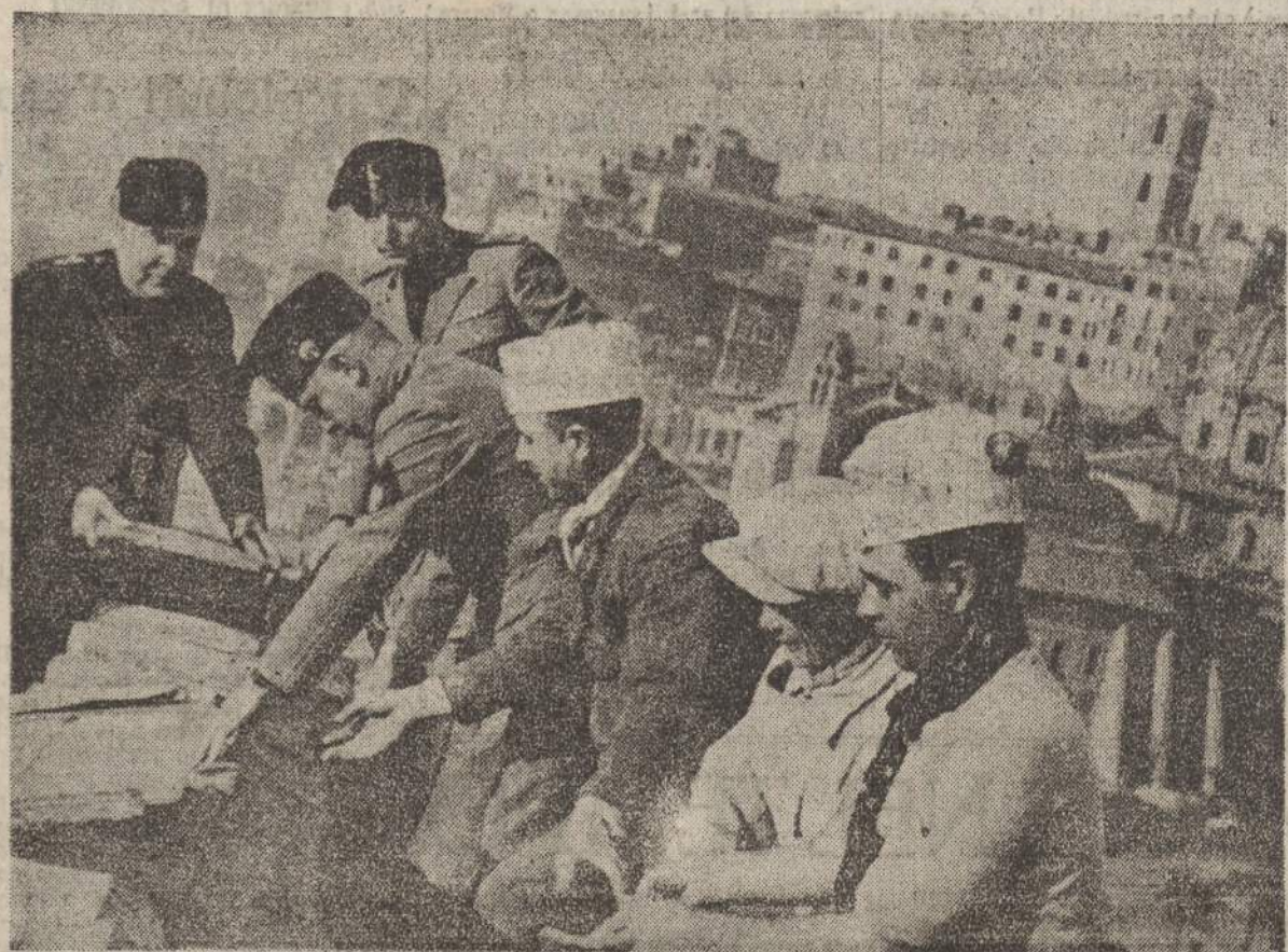
Muscolini dà inizio alle demolizioni nell'area in cui sorgeva la Molo Littoria
