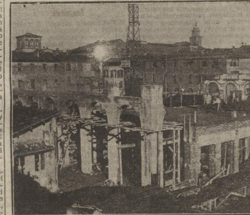
IMOLA — Lavori interni al «Centro Cittadino» (Fot. Ferlini, Imola)
