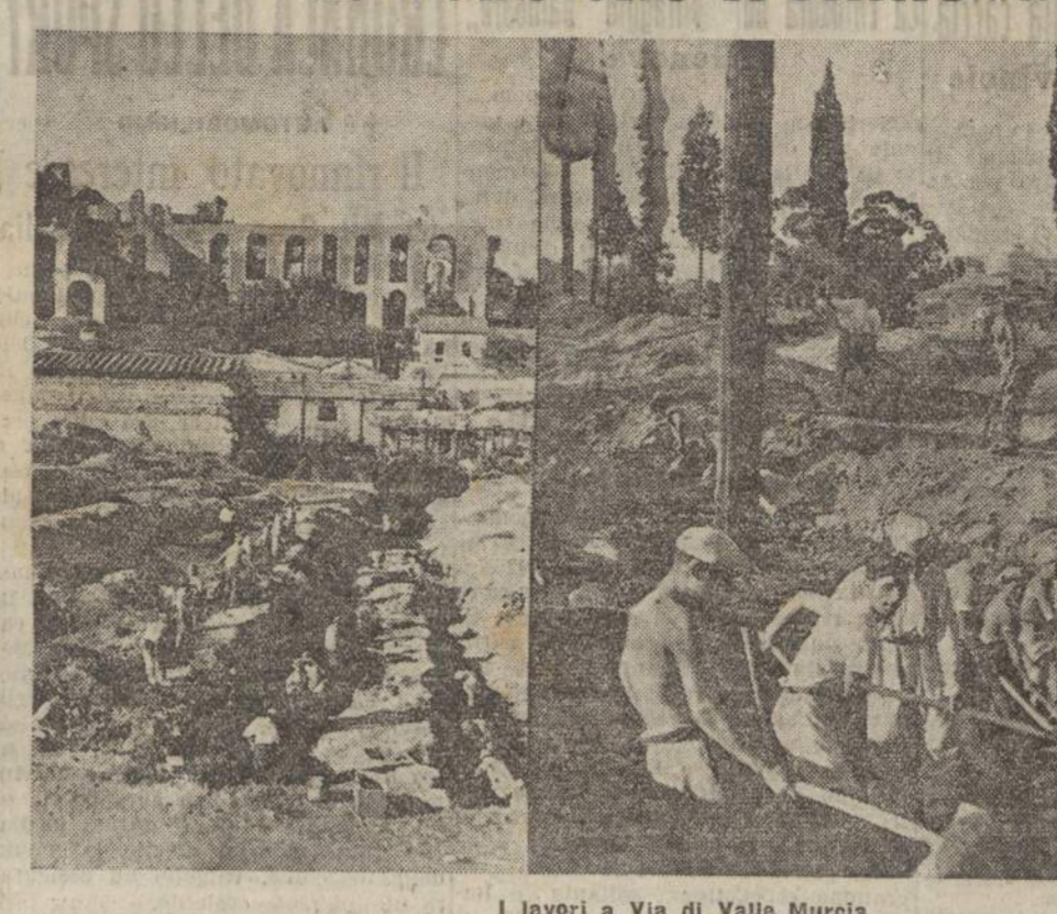
I lavori a Via di Valo Murio
