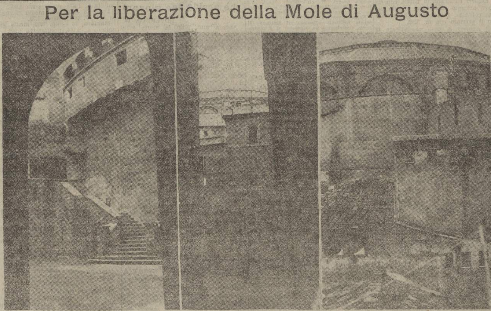
A Roma si sono iniziati i lavori per la liberazione della Mole di Augusto. Da sinistra a destra: 1) l'attuale ingresso all'Augusteo nel fianco della millenaria Mole; 2) uno degli scavi crollati che verranno demoliti; 3) la cupola che emerge dalle casupole destinate all'estermidio del piccone con tutte le sovrastrutture accumulate dal tempo.
