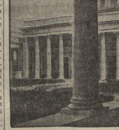
La facciata della Basilica vista dal chiostro
