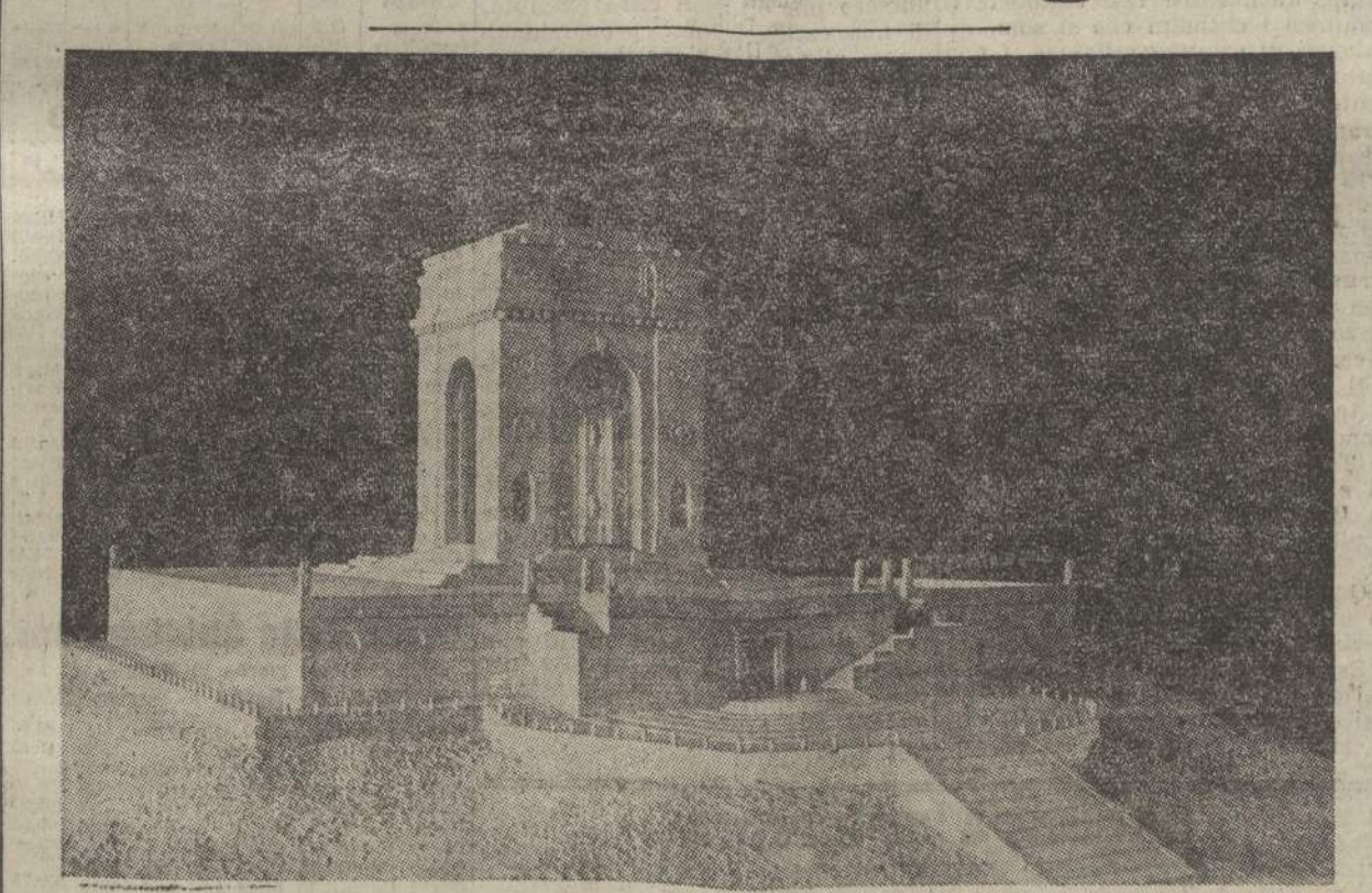
Il grandioso Ossario di Asiago in corso di costruzione
