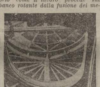
Una delle rampe elicoidali dello stabilimento.
