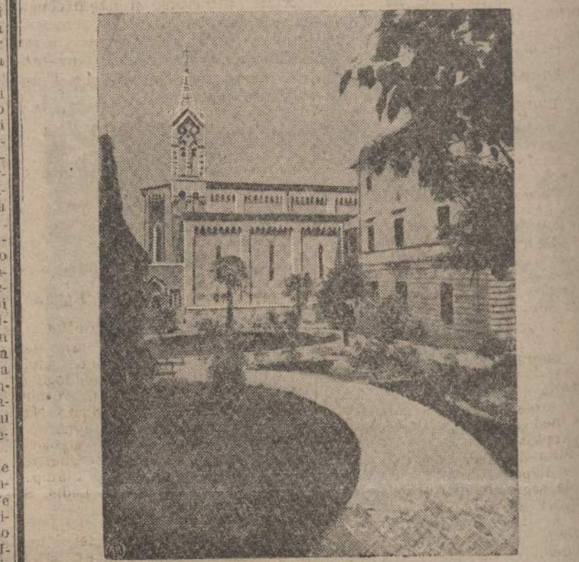
Giardino-Cappella (ato ovest dell'Istituto)
