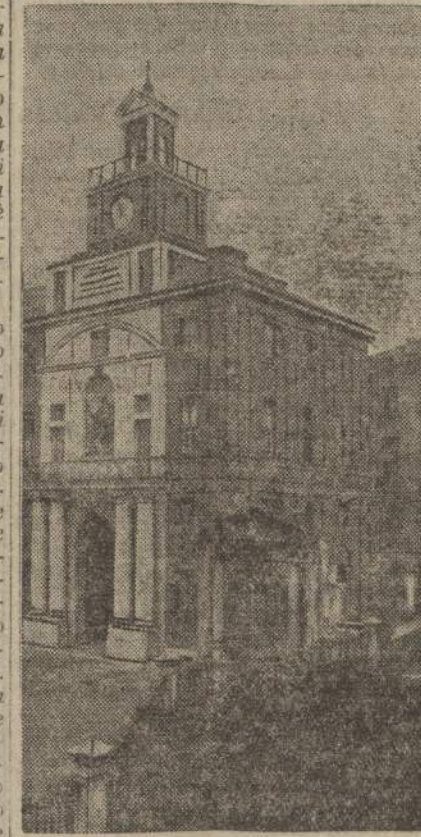
La facciata vista di scorcio
