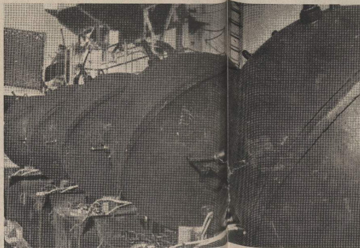
Den Minen werden die «Hörner» aufgesetzt: Bleikappen, in denen sich beim Anstossen die Zündung auslöst. ◇ Vengono montati suell mine i «corni», astucci di piombo, nei quali all'urto avviene l'accensione. ◇ Minam nasadjajo «rogove»: svinčene kapice, ki se vnamejo pri udarcu. ◇ Minama nasadjaju «rogove»: olovne kapice, u kojima se pri udaru izaziva paljenje.
