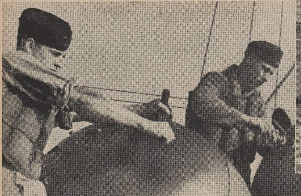
Den Minen werden die «Hörner» aufgesetzt: Bleikappen, in denen sich beim Anstossen die Zündung auslöst. ◇ Vengono montati suell mine i «corni», astucci di piombo, nei quali all'urto avviene l'accensione. ◇ Minam nasadjajo «rogove»: svinčene kapice, ki se vnamejo pri udarcu. ◇ Minama nasadjaju «rogove»: olovne kapice, u kojima se pri udaru izaziva paljenje.
