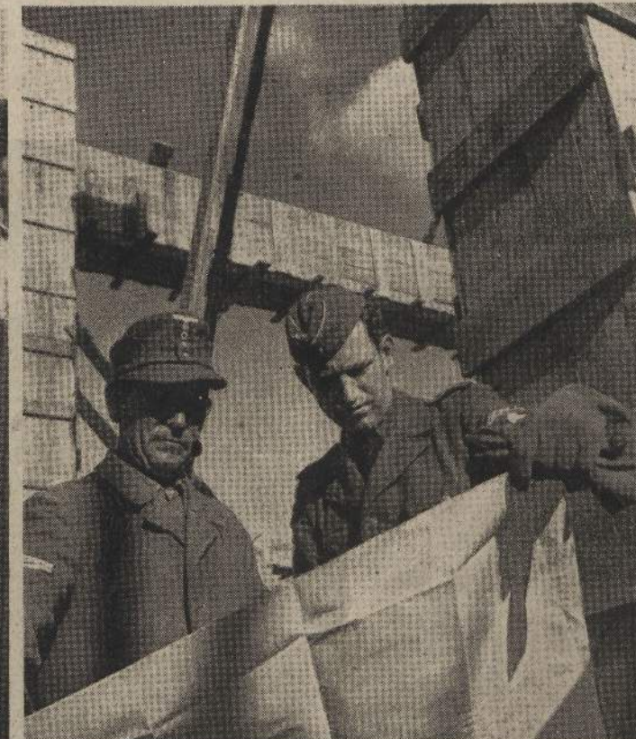
Unter der Leitung bewährter Ingenieure entstehen Bunker um Bunker, die die Küsten der Adria schützen. ♦ Sotto la direzione di esperti ingegneri si costruiscono le trincee per la difesa delle coste adriatiche. ♦ Vešči inženirji vodijo zidavo cele vrste utrdbe, ki varujejo jadransko obalo. ♦ Pod vodjstvom prokušanih inženjira nastaje bunker za bunker, koji štite obale Jadranskog mora.
