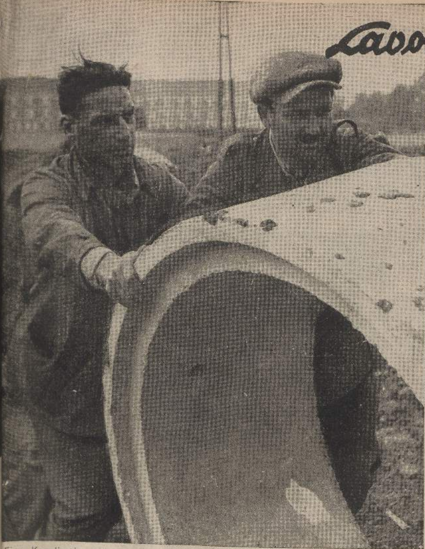
Eine Kanalisationsröhre wird zusammengebaut. ♦ Si costruisce un tubo per la canalizzazione. ♦ Pri gradnji kanalizacijske cevi. ♦ Sastavlja se ciev za kanalizaciju.
